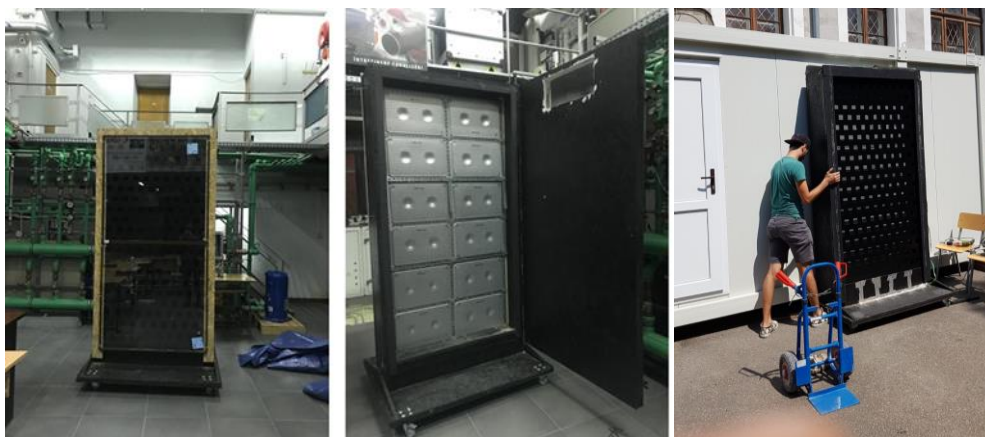
Fig. 22. Construcția colectorului solar optimizat / integrarea colectoarelor solare pe clădirea test
