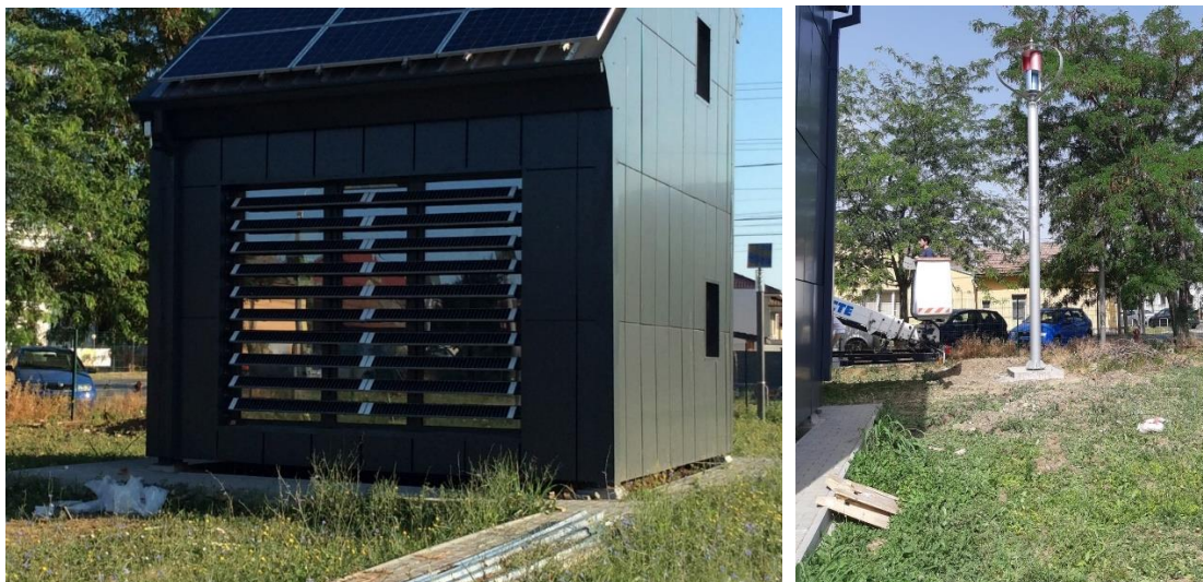
Fig. 24. Montajul lamelor fotovoltaice și a turbinei eoliene
